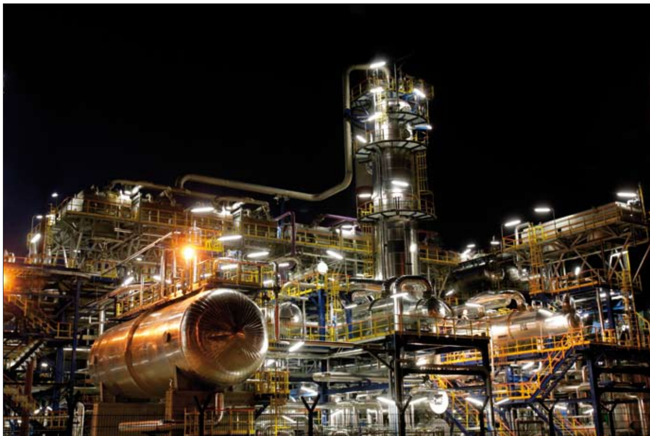
Fot. 2. Widok nowo wybudowanych instalacji rafinerii Grupy LOTOS S.A.
