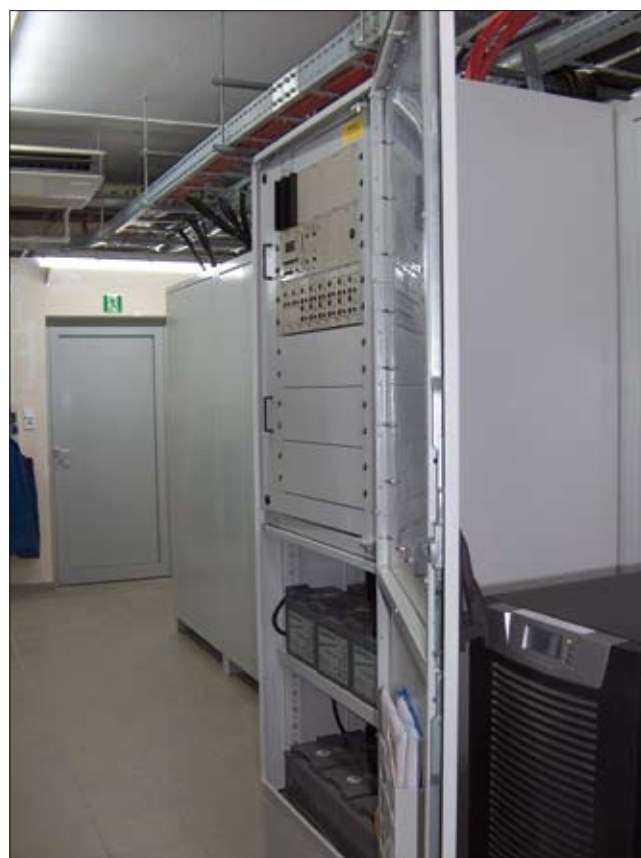
Rys. 3. Bateria centralna w sterowni
